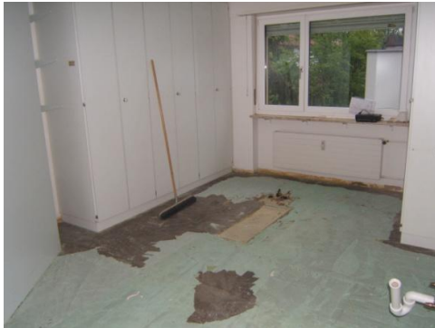
Baustelle im Zahnreinigungs-Zimmer
